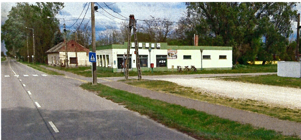
A felújítani tervezett épület
